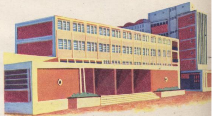
En Ghana, el calor solar se utiliza para mantener en constante movimiento el aire de los edificios. El sol calienta las paredes; el aire interior asciende y sale por unos orificios en forma de embudo.
